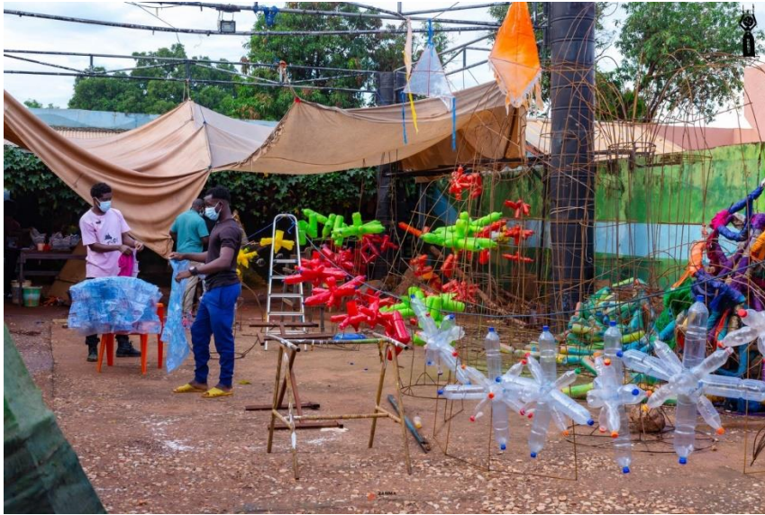
Atelier construction scénographie Burkina Faso octobre 2024
